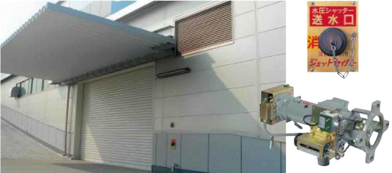
減速機のノウハウを応用したシャッター駆動装置。その中でもジェットセイバーは優れた技術力を結集して開発した電動シャッター水圧開放装置です。非常の際、消防車の強力な送水圧で外部よりタービンを回し、シャッターを開放。わずか1分で消防隊が消火活動に移れる状態にし、かけがえのない人命の救出や、大切な財産の消失防止に役立ちます。シャッターを破壊することなく、初期消火活動を可能にする「ジェットセイバー」は、大型のシャッターが設置されている工場、倉庫および大型店舗で絶大な効果を発揮します。
